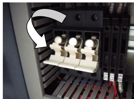
Fig. 06.11 – Accessibilité aux fusibles
