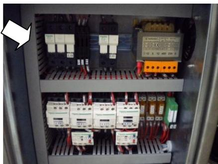
Fig. 6.10 – Accessibilité aux fusibles
