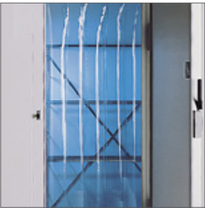
Cortina de lamas de plástico para preservar la temperatura interior de las cámaras durante las aperturas de puertas. El espesor de cada lama es 1,8 mm y la anchura es de 20 cm.
