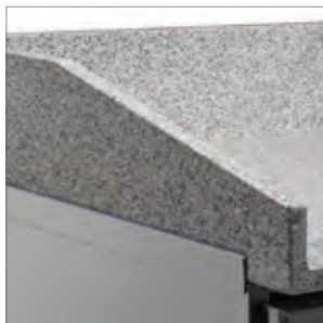
20 cm de peto construido en granito.
