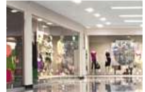
Local comercial con fancoils
