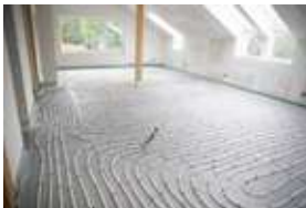
Sustitución de calderas para instalaciones domésticas de suelo radiante
